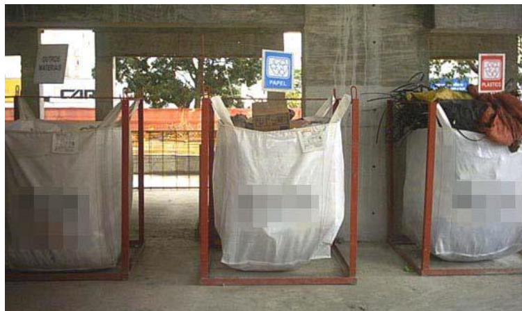
Figura 9 – Organização de resíduos em canteiro de obras
