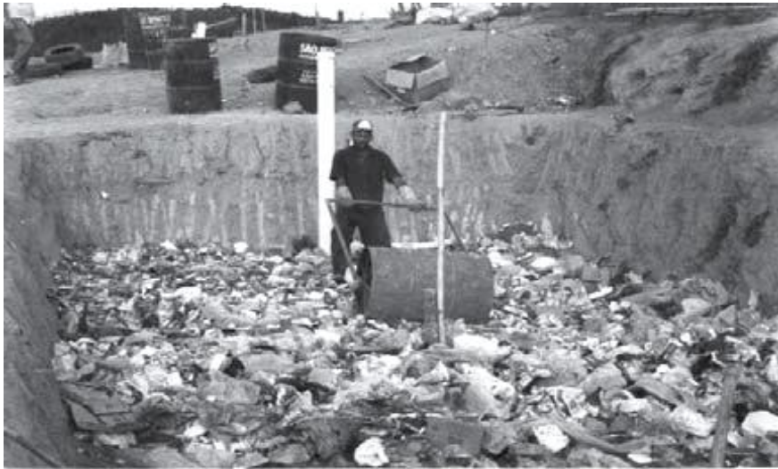
Figura 36 – compactação dos resíduos.
